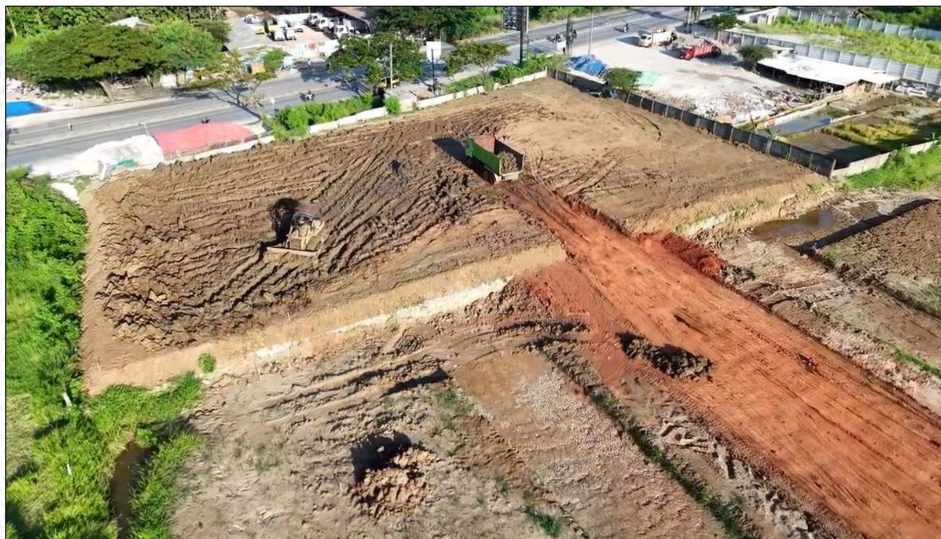
Pekerjaan Pembersihan Lahan dan Pengurukan Tanah untuk Lahan Komersial
